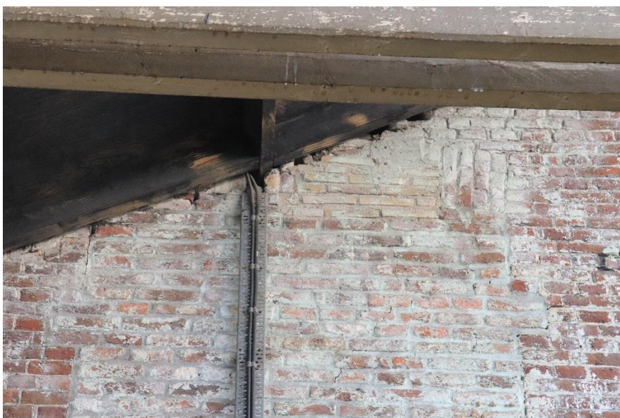
Foto 2: op vele plekken zijn er wegcruipmogelijkheden tussen de muren en het dakbeschoot, geschikt als zomerverblijf, maar ook als winterverblijf
